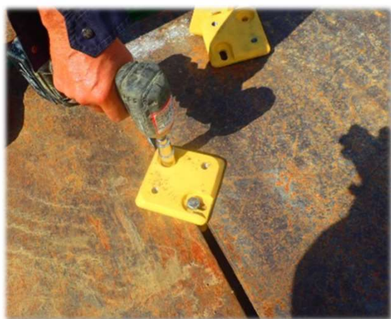
電動工具で締め付けが可能です。
